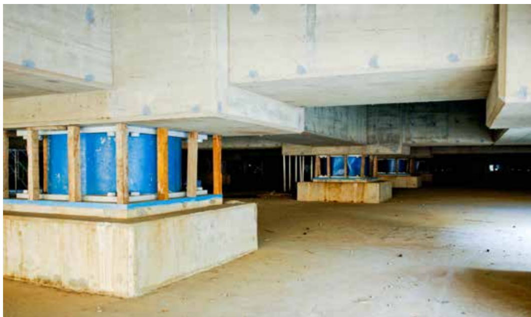
隔震墊把建築物撐起，可以直接吸收五、六成地震傳來的能量。圖為臺中慈濟醫院二期工程隔震墊組立現況。攝影／曾東勝
