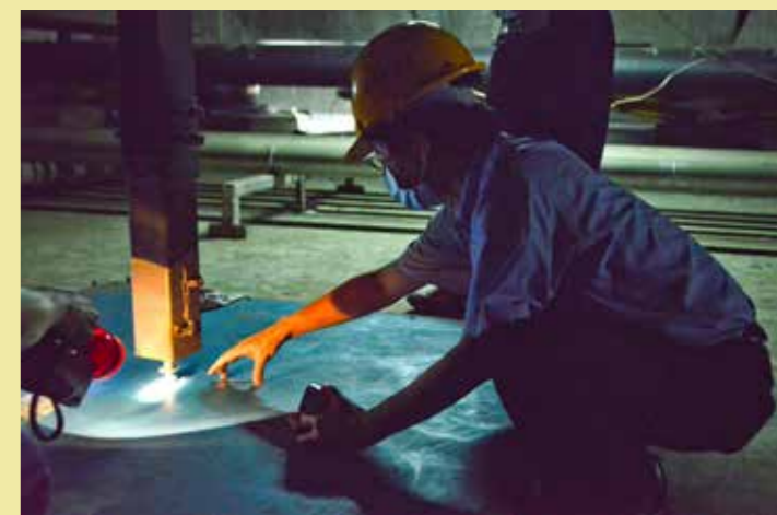
地下隔震系統中會設立位移指針來檢驗地震後建物與隔震墊承受的應力是否都被吸收與消耗，臺北慈院位於地震頻繁的臺灣，位移指針仍回復原點，令檢核工程師大為讚嘆。攝影／徐莉惠
