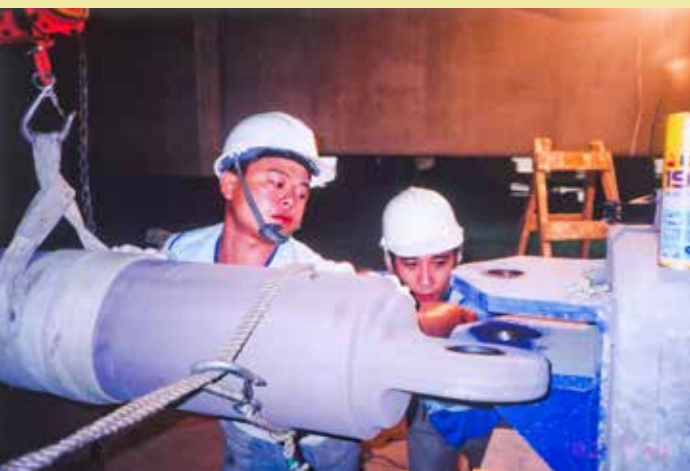
工程領班周正鵬微微移動一點八四公噸重的「液壓桿組尼器」，對準「鎖」孔。攝影／劉鼎龍
