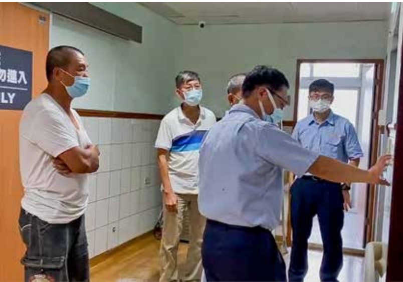
基金會營建處鄧乃仁師兄（右二伸手者）與林珀州股長（右一）帶領施工人員逐一檢視需整修的位置。圖／玉里慈院提供
