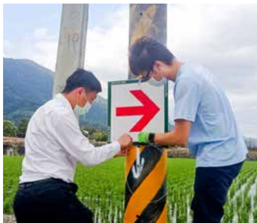
同仁用心準備路跑前置作業。圖為總務股資訊室同仁陳正邦（左）與潘彥廷至賽道設置路線指示牌。
