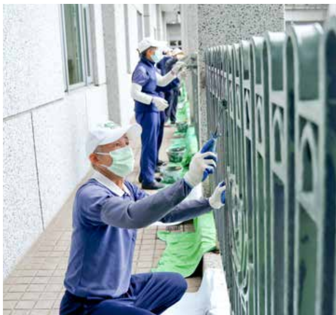
志工在炎熱的天氣下修護陽臺欄杆、除鏽。攝影／盧義泓
