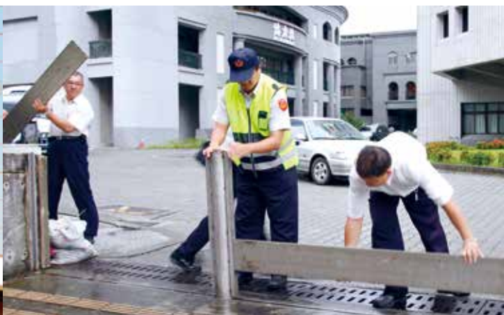
總務室警勤組同仁正在放置地下停車場入口的防水擋板。攝影／彭微勻
