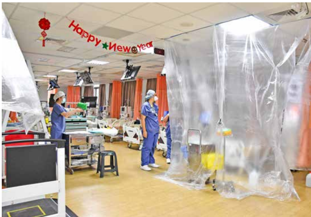
專責病房尚未完成前，高風險及確診病人集中在原單位夜間透析，並以透明膜及防塵袋隔出工作區、病人區、除汙區，安裝排風扇加強通風效果。
