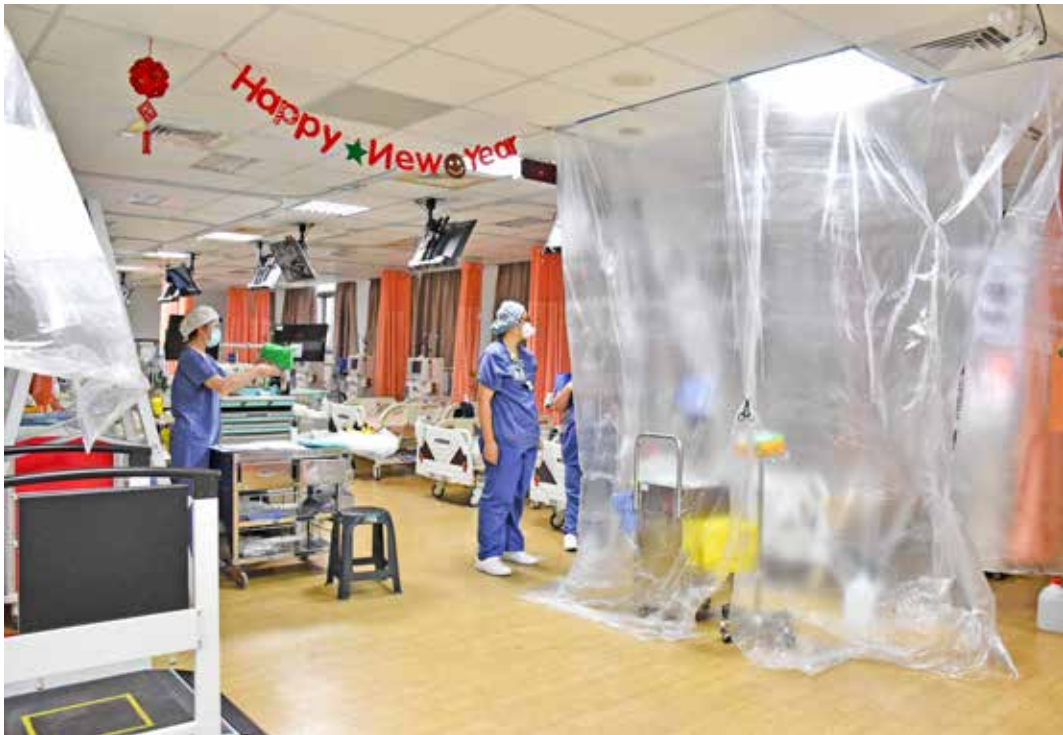
專責病房尚未完成前，高風險及確診病人集中在原單位夜間透析，並以透明膜及防塵袋隔出工作區、病人區、除汗區，安裝排風扇加強通風效果。
