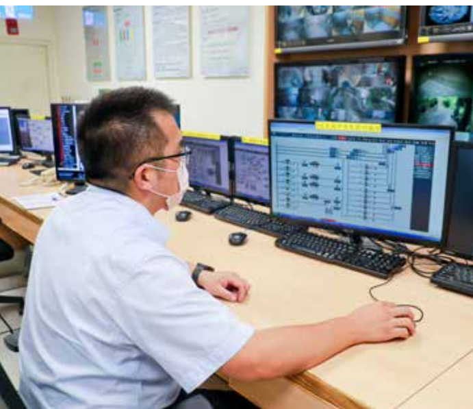
工務室結合工研院能源管理系統 (EMS) 與 Honeywell 中央監控平臺，導入「智能空調管理系統」，以軟硬體整合達成精準節能減碳目標。攝影／卓冠伶
